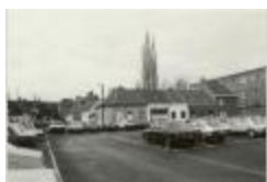
parking Muylenberg (Foto 07036-07)
