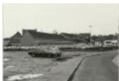
Parking Muylenberg (Foto 07036-10)
