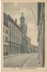
Turnhout, Herenthalsstraat Turnhout - Entrée du Béguinage (Prentbriefkaart 29_038)
