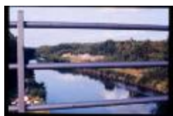
Fiets- en voetgangersbrug (Dia container 3_14)
