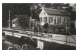
Brugwachtershuis aan brug 8 (Meirgoren) (Foto 05825_01)
