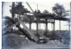
Bouwen van een brug (Glas_04_84)
