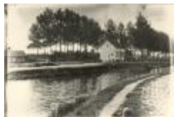
Brug 1 over het kanaal (Foto 01507-01)
