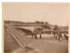
Brug over kanaal / belastingsproef (Foto 02180_01; 02180_02; 02180_03)
