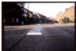
Elf Novemberlaan overrijdbare middengeleider (container 28_136)
