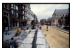
Heraanleg (Dia container 38_3435)
