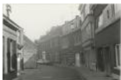
Driezenstraat / heraanleg (Foto 07029-02)
