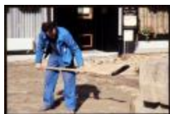
Wegwerkzaamheden (Dia container 38_3458)
