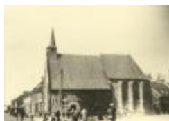
Oprichten van electriciteitspaal aan Theobalduskapel (Foto 05037_01; 05037_02)
