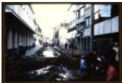
Otterstraat - Werken heraanleg (Dia's container 36_492 + 93)
