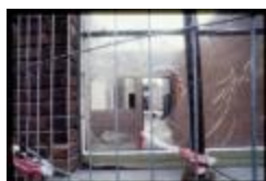
Verbouwwerken (Dia container 38_3421)
