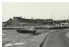
Parking Muylenberg (Foto 07036-10)
