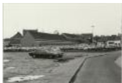
Parking Muylenberg (Foto 07036-10)
