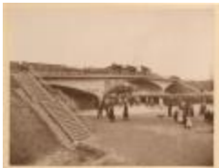
Brug over kanaal / belastingsproef (Foto 02180_01; 02180_02; 02180_03)
