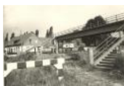
Voetgangers/fietsbrug over de Vaart (Foto 00672_01; 05222_01)
