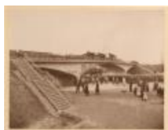
Brug over kanaal / belastingsproef (Foto 02180_01; 02180_02; 02180_03)
