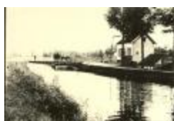
Kanaal aan brug 1 (Foto 04272_01)
