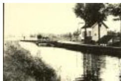
Kanaal aan brug 1 (Foto 04272_01)
