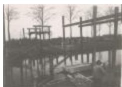
Bouwen van een kanaalbrug (Foto 05476_01; 05476_02)
