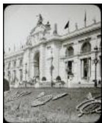
Exposition de Bruxelles - Facade principale - coté gauche (Glas1120)
