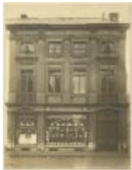
Gasthuisstraat / gevel (Foto 04224_01)
