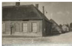
's Hertogenhoeve en schuur (Foto 01633-03 en 07)
