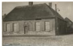
's Hertogenhoeve en schuur (Foto 01633-06 en 08)
