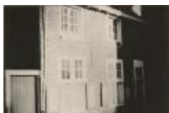
Begijnhof: gevel (Foto 03197_01)
