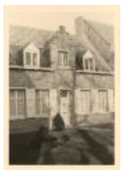
Begijnhof: gevel (Foto 03162_01)
