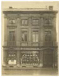
Gasthuisstraat / gevel (Foto 04224_01)
