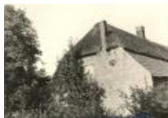
's Hertogenhoeve en schuur (Foto 01633-04 en 05)
