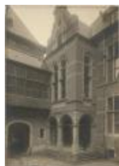
Binnenkoer van het kasteel (Foto 00202_06; 00202_08)
