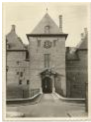
Ingangspoort kasteel (Foto 00208_01; 00208_02; 00208_05)
