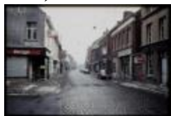
Otterstraat - Hoek Klinkstraat (Dia's container 36_464 + 65)
