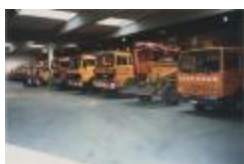
Het nieuwe stadsmagazijn in Everdongenlaan / interieur (Foto 06551-09)
