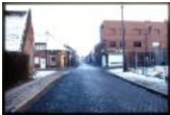
Hoek Baron Frans du Fourstraat - Hoveniersstraat (Dia container 36_449)
