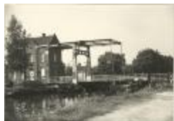
Brug 1 over de Vaart (Foto 00672_02)
