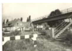
Voetgangers/fietsbrug over de Vaart (Foto 00672_01; 05222_01)
