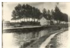
Brug 1 over het kanaal (Foto 01507-01)
