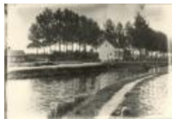
Brug 1 over het kanaal (Foto 01507-01)
