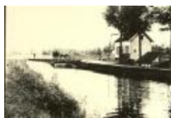
Kanaal aan brug 1 (Foto 04272_01)
