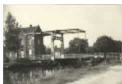
Brug 1 over de Vaart (Foto 00672_02)
