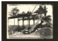
Brug leggen over het kanaal (Foto 03241_01 t.e.m. 03241_03)
