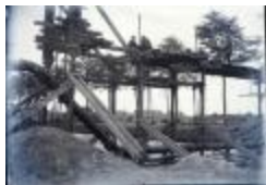
Bouwen van een brug (Glas_04_84)
