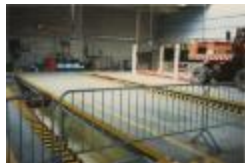
Het nieuwe stadsmagazijn in Everdongenlaan / interieur (Foto 06551-07)
