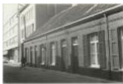
Driezenstraat / heraanleg (Foto 07030-05)
