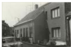
Driezenstraat / heraanleg (Foto 07030-06)
