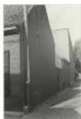
Driezenstraat / heraanleg (Foto 07030-10)
