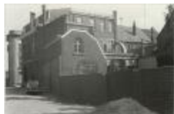
Driezenstraat / heraanleg (Foto 07030-07)
