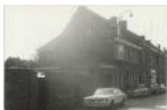
Driezenstraat / heraanleg (Foto 07029-07)
