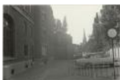
Driezenstraat / heraanleg (Foto 07029-08)
