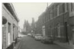
Driezenstraat / heraanleg (Foto 07029-05)
