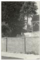
Driezenstraat / heraanleg (Foto 07029-10)
