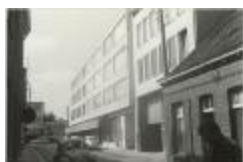
Driezenstraat / heraanleg (Foto 07029-06)
