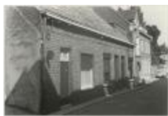
Driezenstraat / heraanleg (Foto 07030-03)
