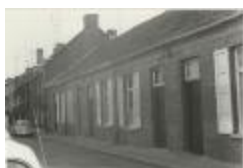
Driezenstraat / heraanleg (Foto 07029-12)
