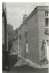
Driezenstraat / heraanleg (Foto 07030-12)
