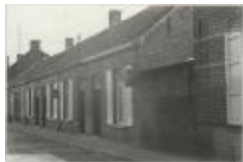
Driezenstraat / heraanleg (Foto 07029-11)
