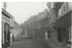
Driezenstraat / heraanleg (Foto 07029-02)
