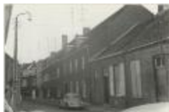
Driezenstraat / heraanleg (Foto 07029-03)
