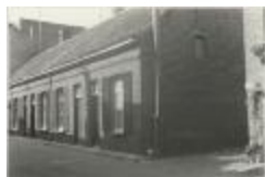
Driezenstraat / heraanleg (Foto 07030-11)
