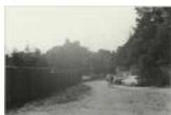
Driezenstraat / heraanleg (Foto 07030-09)
